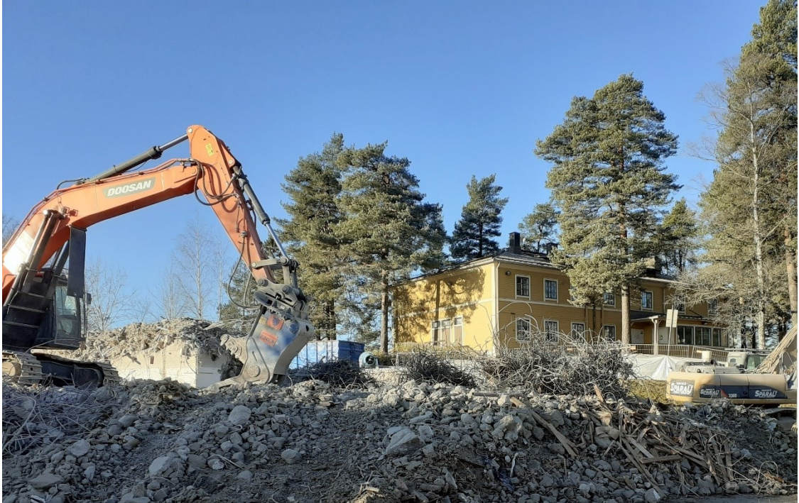
Kuva Heini Liimatainen, kaupungintalon purkutyömaa Seuratalon edustalla
